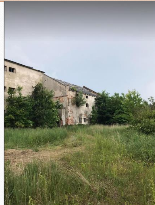
Budynek gospodarczy znajdujący się za pałacem (zdjęcie własne)
