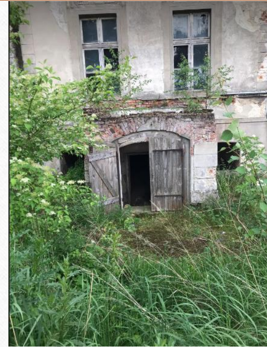
Wejście do piwnicy pałacu od strony północno-zachodniej (zdjęcie własne)
