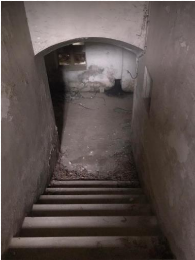
Wejście do piwnicy (zdjęcie własne)
